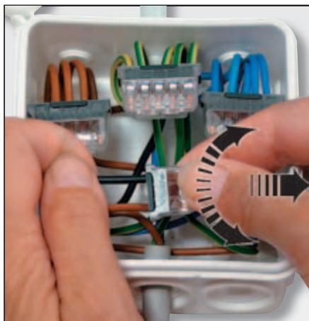
Отсоединение кабеля выкручиванием и вытягиванием
