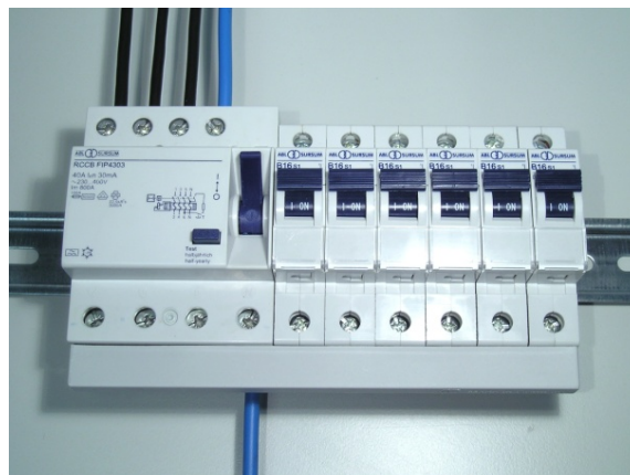
Połączenie szynami fazowymi
