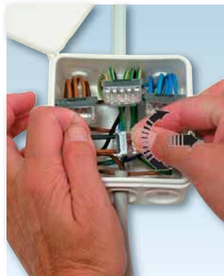
Luzowanie przewodu przez obracanie i ciągnięcie. Uvolnění vodiče otočením a vytažením.
