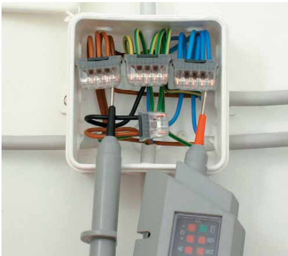
Kontrola skrzynki rozdzielczych z pomocą próbnika elektrycznego \varnothing 2\text{ mm} Kontrola zkušebním kolíkem v elektroinstalační krabici na omítku \varnothing 2\text{ mm}
