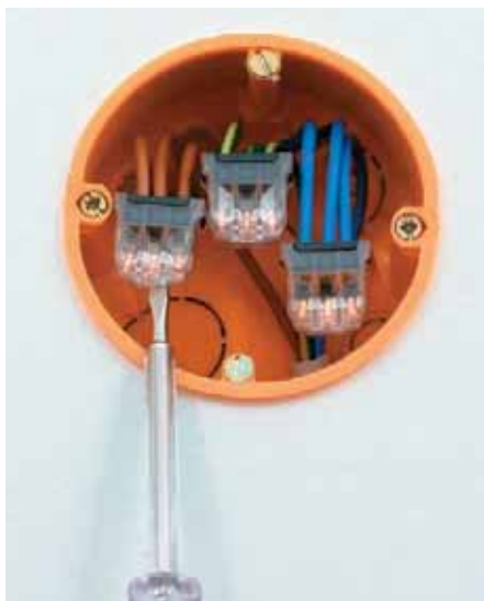
Skontrolować przy pomocy próbnika fazowego \varnothing 2\text{ mm} Kontrola fázovou zkoušečkou \varnothing 2\text{ mm}
